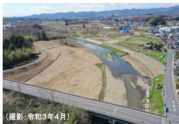
▲樹木伐採、築堤工事が完了した越辺川（今川橋付近）
