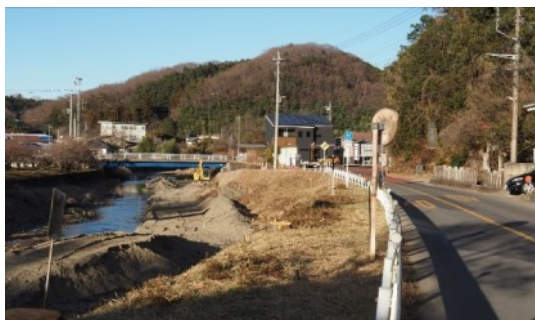
▲梅園神社前の歩道未整備区間
