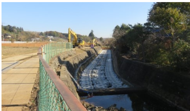
▲鳩川の工事の様子
