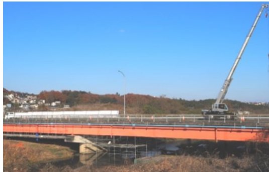
▲越生大橋の工事の様子
