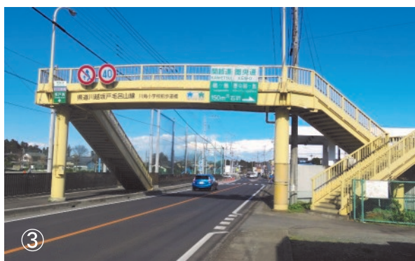
▲川角小学校前歩道橋
