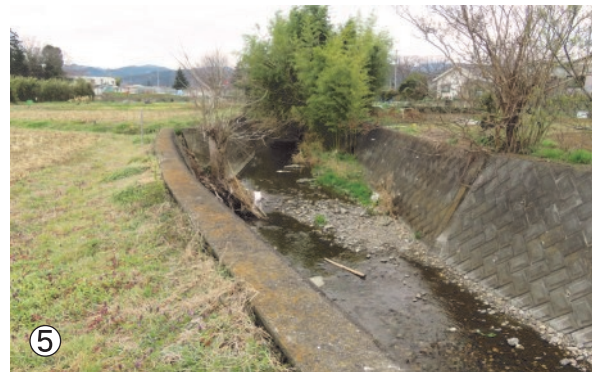
▲大谷木川（長瀬地内）
