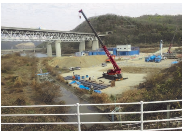
▲河川改修工事が進む現地
