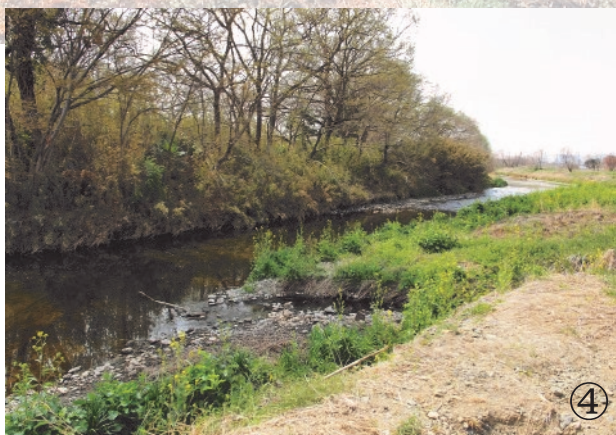
▲河川改修に向け用地測量が広がる越辺川（苦林地内）
