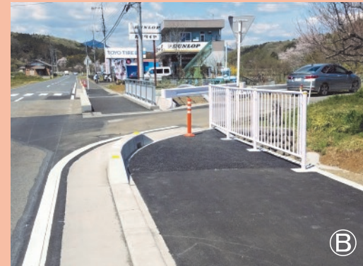
▲完成した熊井地内の歩道
